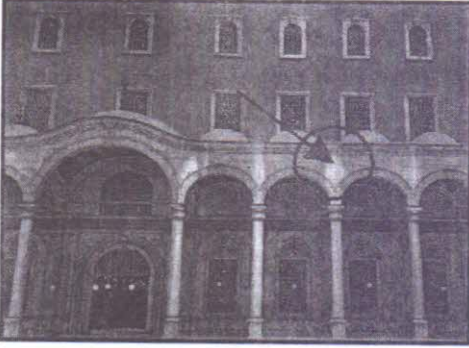
صورة رقم (٩) تبين تأثير المطر الحمضي علي الحجر ، حيث نلاحظ من الصورة تآكل السطح نتيجة لتفاعل حمض الكبريتك معه (الواجهة الشمالية الغربية من الخارج ) .
